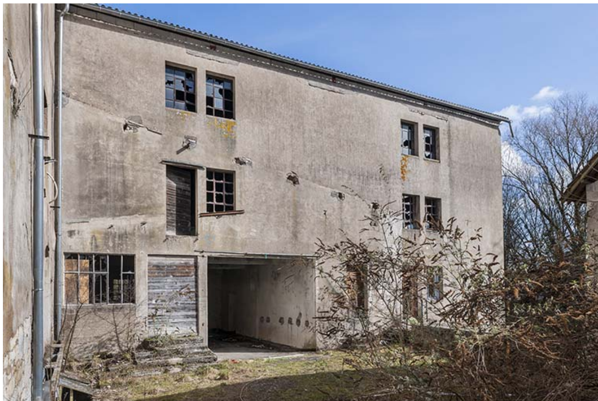
Façade sud du magasin industriel.
