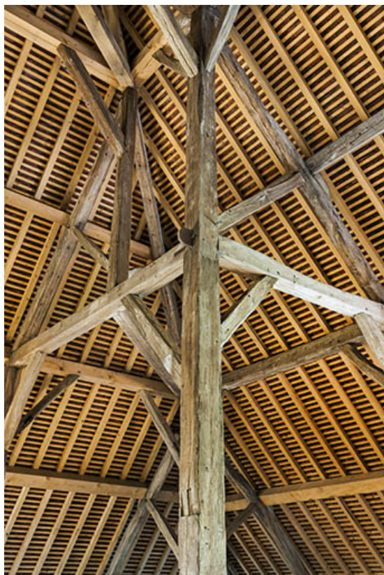
Charpente du séchoir. Détail de la croupe.
