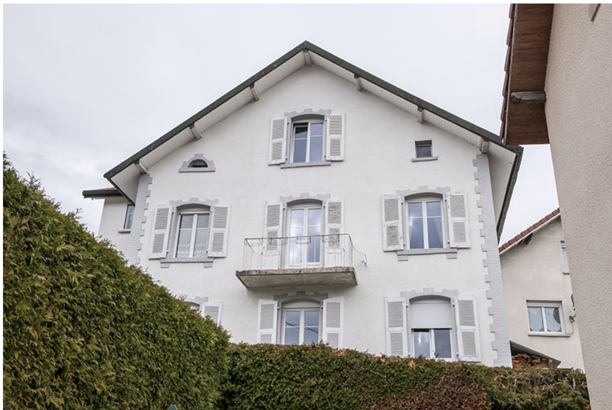
Façade latérale droite, vue en contre-plongée.
