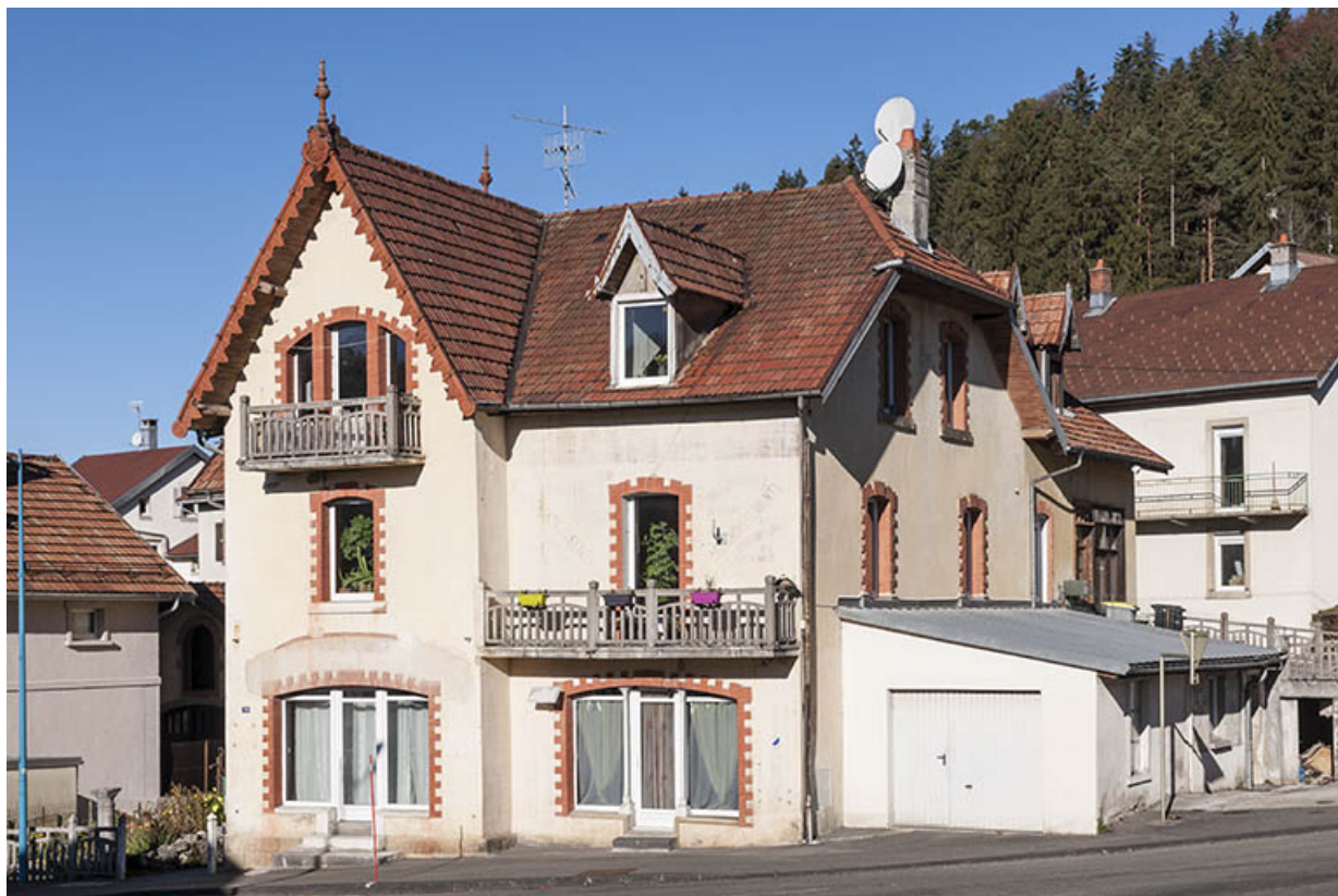
Façades antérieure et latérale droite.
