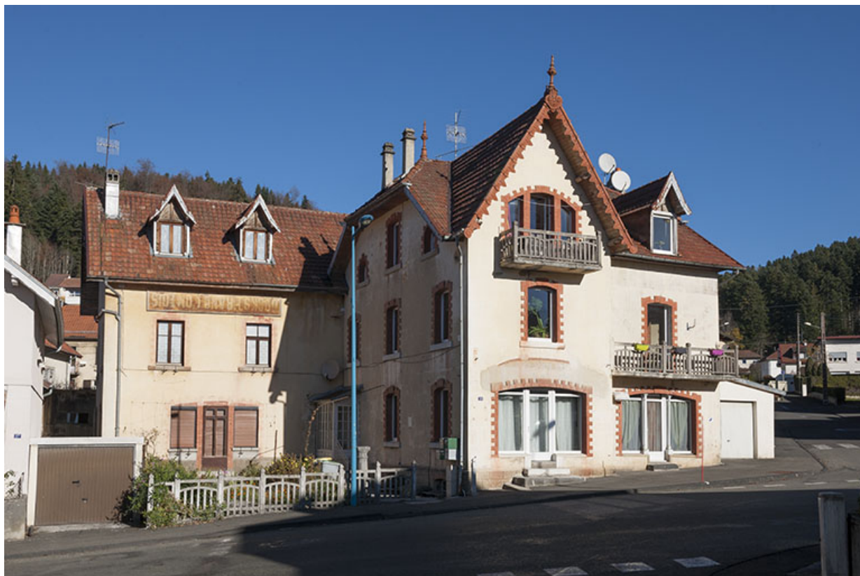
Façades antérieure et latérale gauche.
