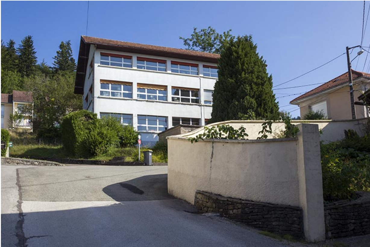
Usine : vue d'ensemble, depuis le sud.
