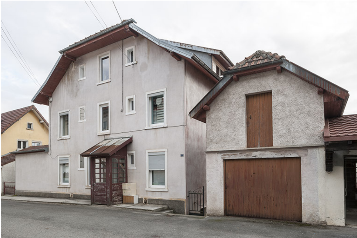
Logement et garage, de trois quarts droite.
