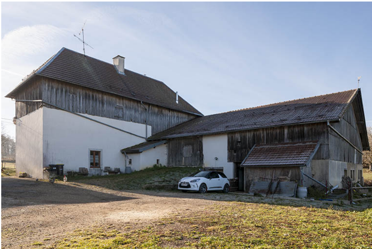
Ferme : façades nord et est.
