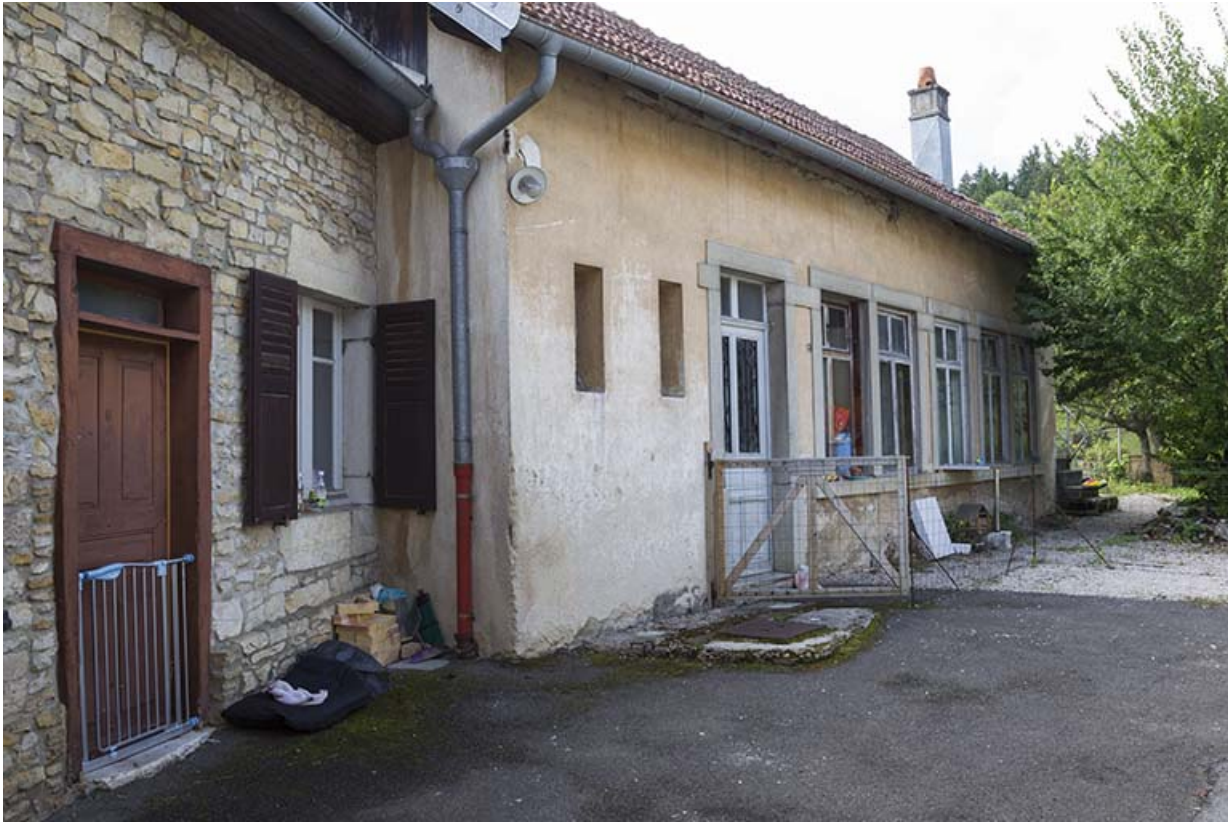
Usine : façade antérieure, de trois quarts gauche.
