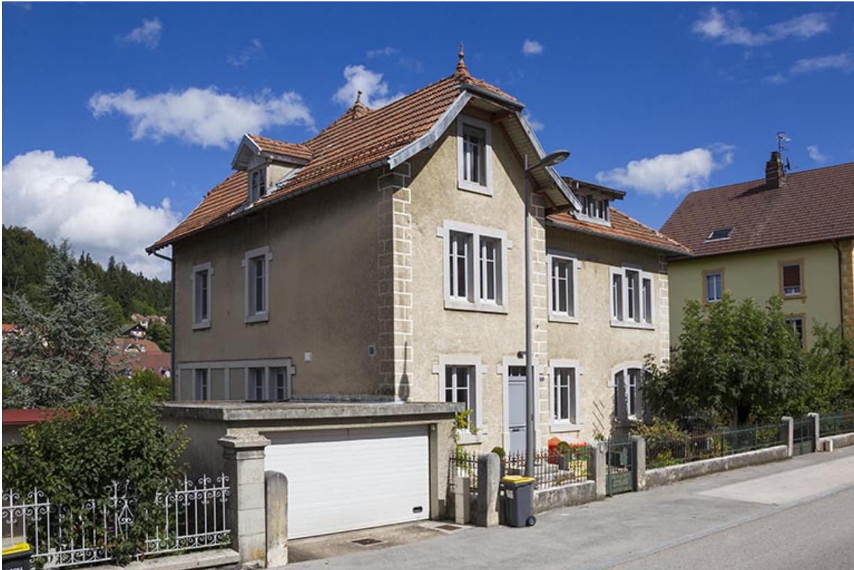
Façades antérieure et latérale gauche.
