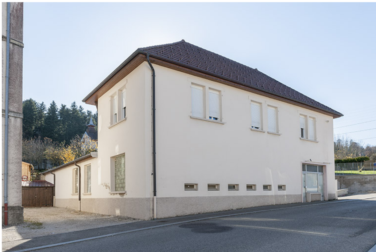
Façades postérieure et latérale gauche.
