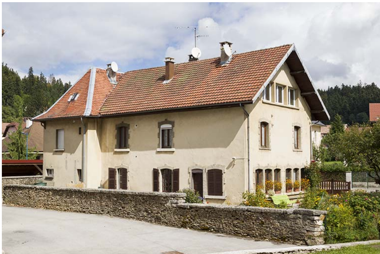
Façades postérieure et latérale gauche.
