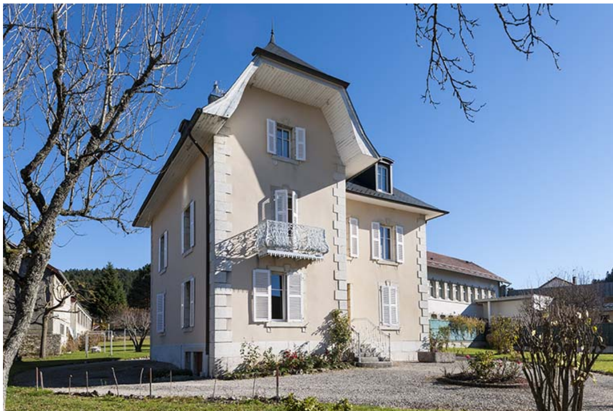
Logement patronal : façades antérieure et latérale gauche.
