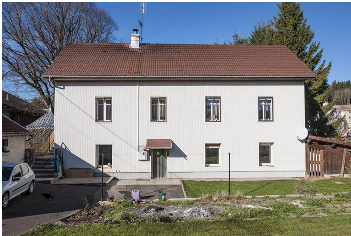
Atelier de fabrication (au n° 6) : façade antérieure.
