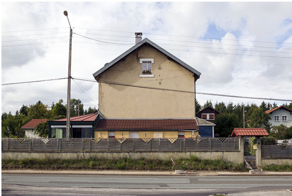
Immeuble au n° 9 : façade latérale sud.
