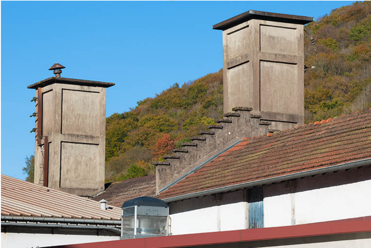
Anciens transformateurs électriques.
