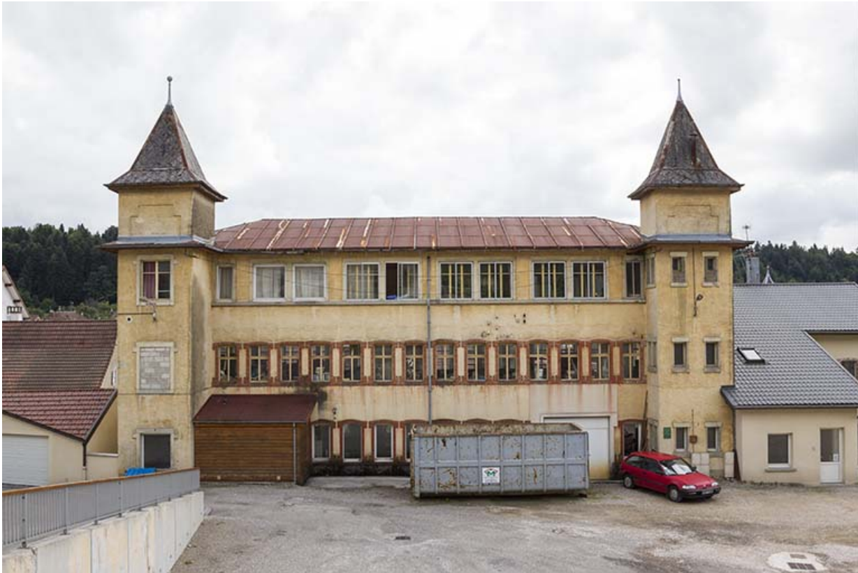
Usine : façade postérieure.
