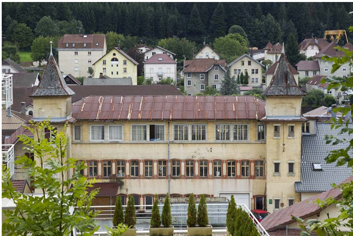
Usine : façade postérieure, vue en plongée.
