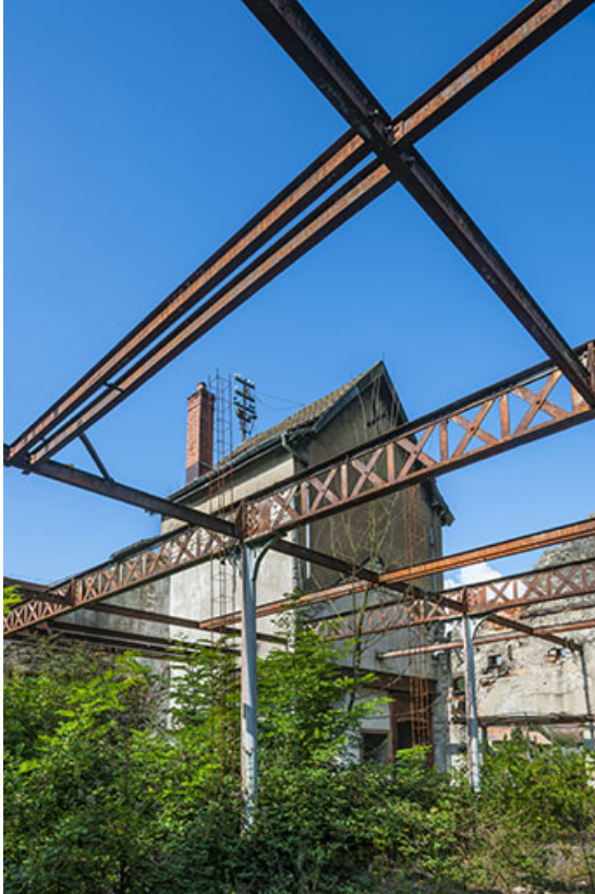
Charpente métallique de l'atelier de fabrication.
