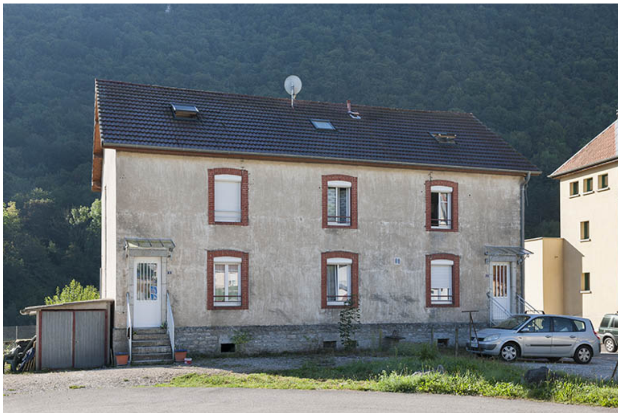
Logement ouvrier (sud) à 4 appartements. Façade ouest.
