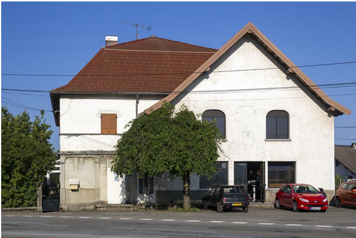
Atelier de fabrication : façade antérieure.
