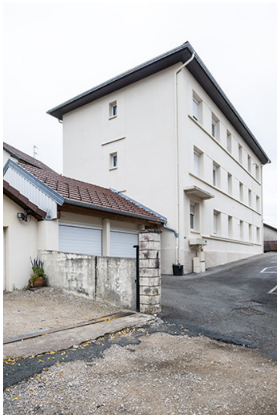
Usine : façades antérieure et latérale gauche.
