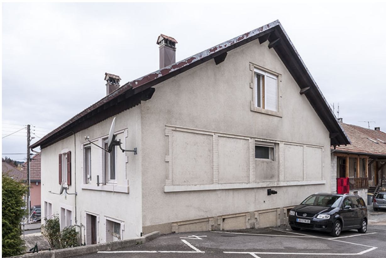
Maison : façades postérieure et latérale droite. 25, Maîche
