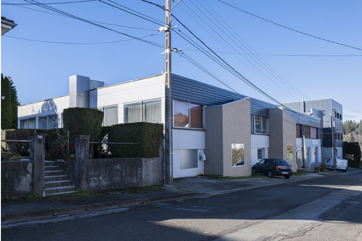
Façades postérieure et latérale droite.
