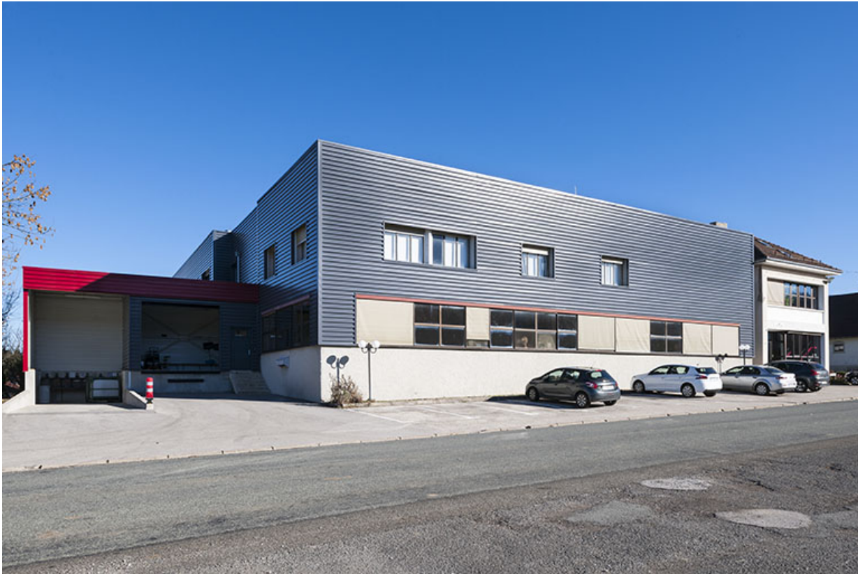
Façade antérieure : ateliers ouest.
