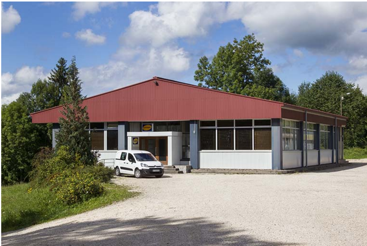
Façades antérieure et latérale droite.
