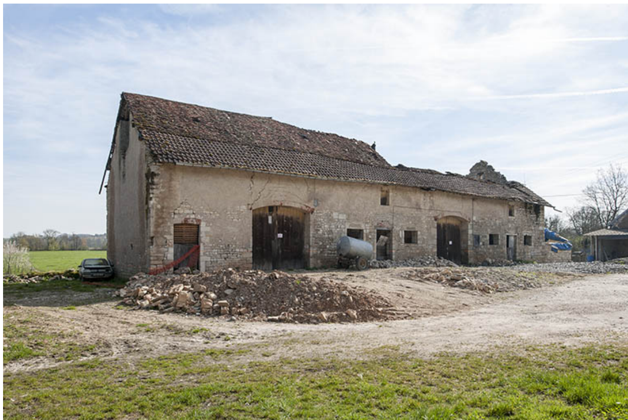
Bâtiment agricole vu de trois quarts gauche.
