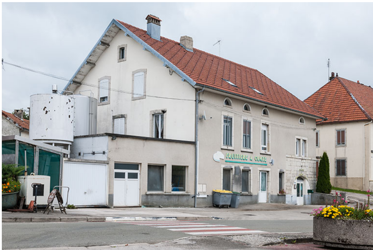
Vue depuis le sud-ouest.
