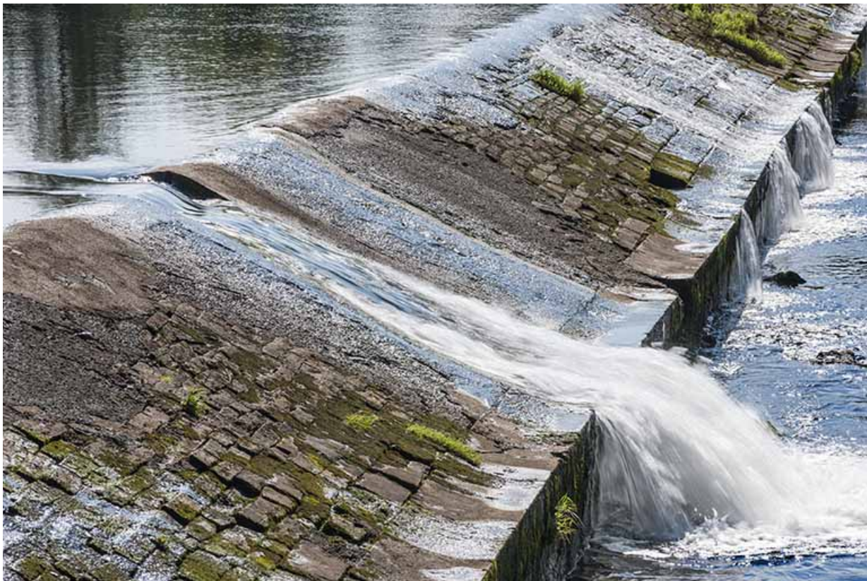
Vue de détail du barrage.
