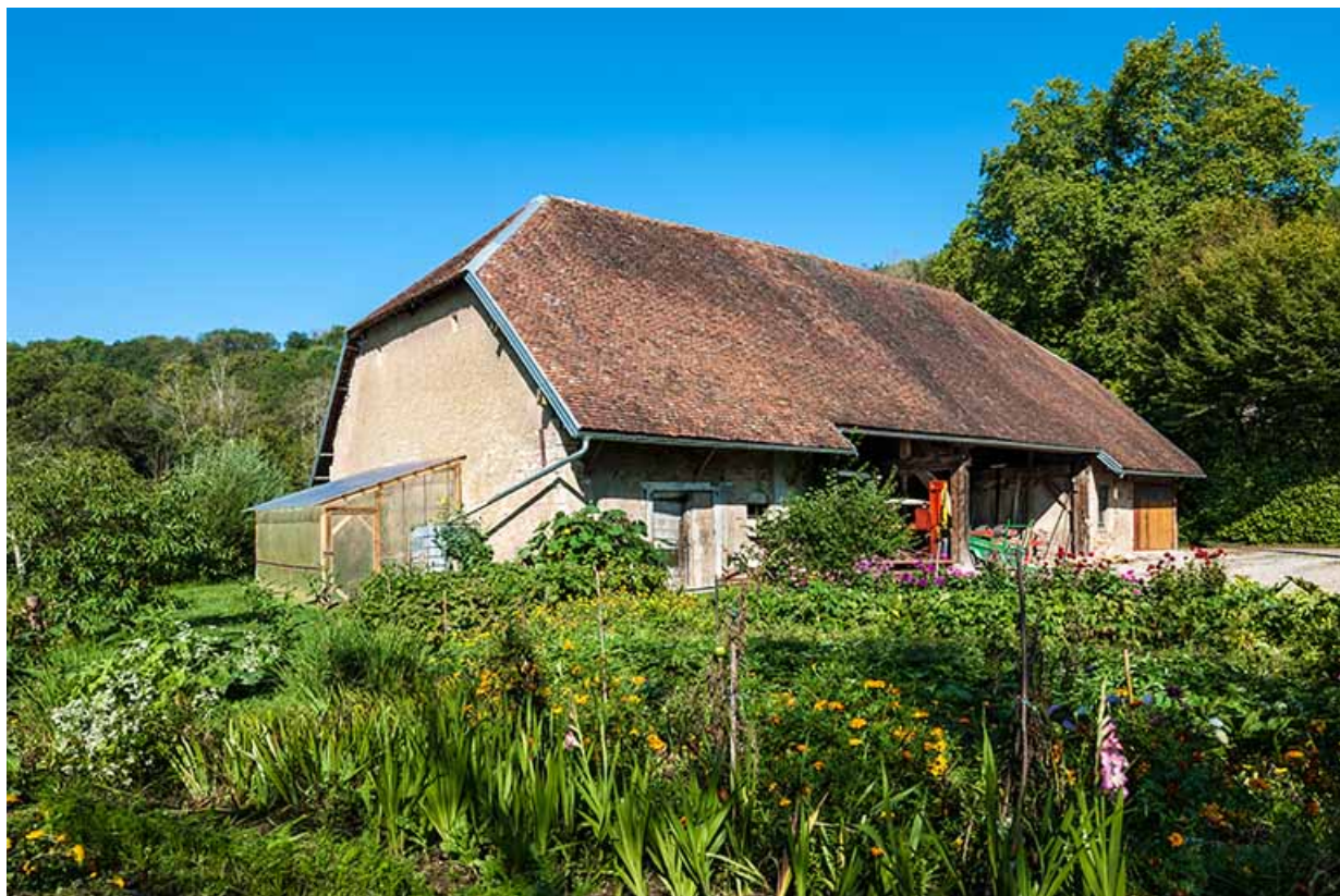
Vue du magasin industriel depuis le sud-est.
