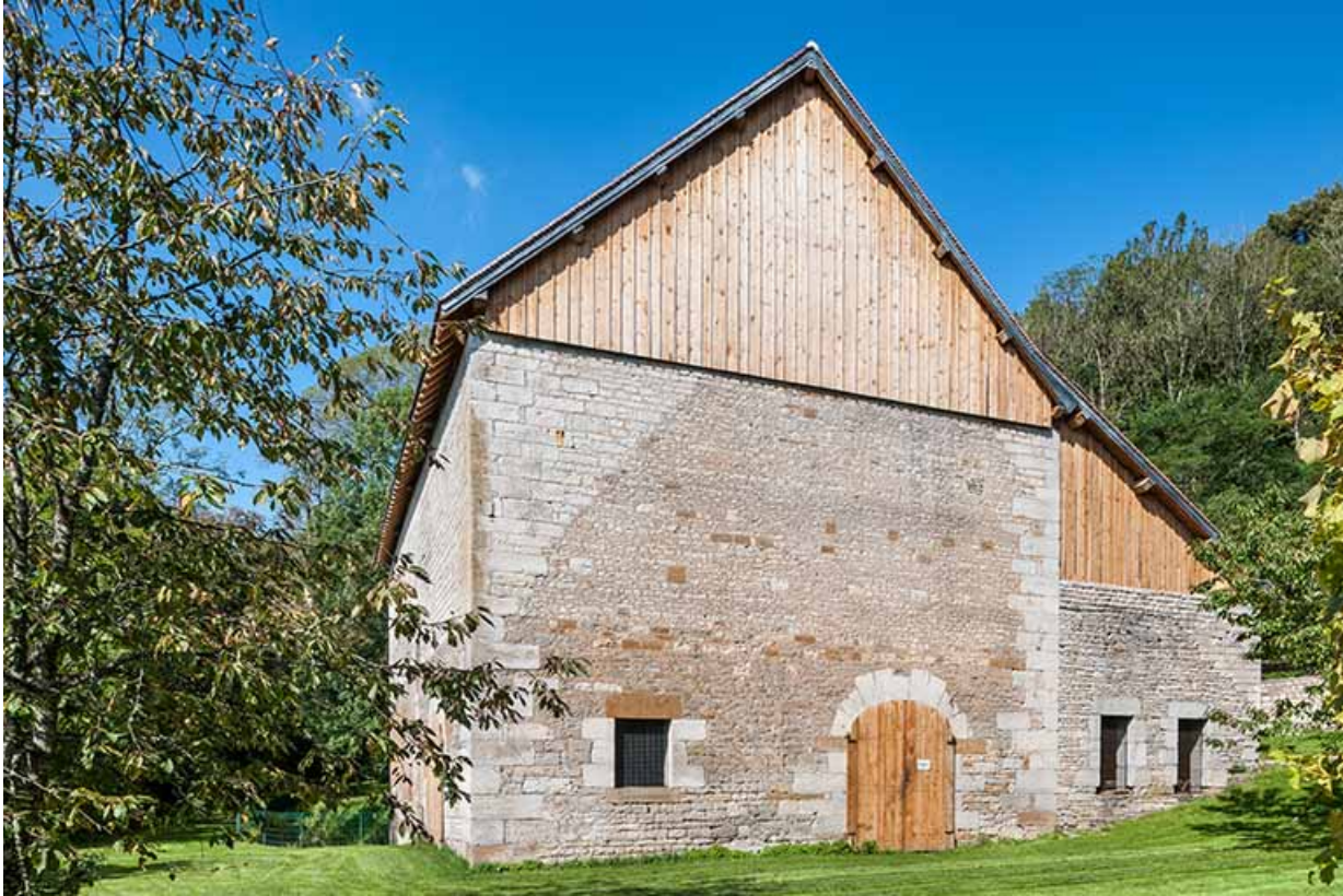
Pignon est du bâtiment du haut fourneau.
