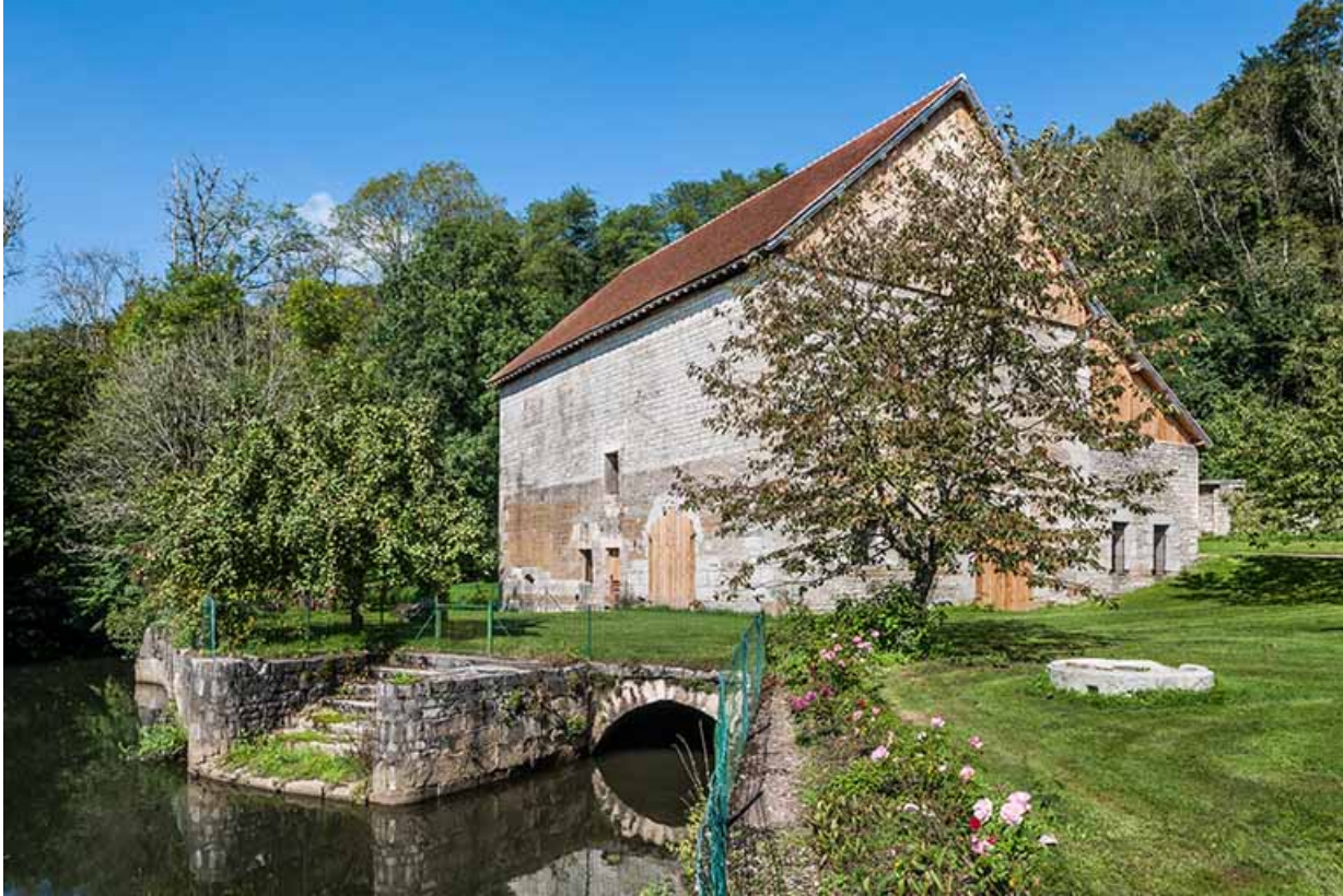
Bâtiment du haut fourneau depuis le sud-est.
