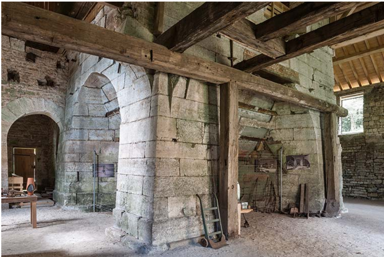
Haut fourneau. Vue rapprochée de trois quarts.
