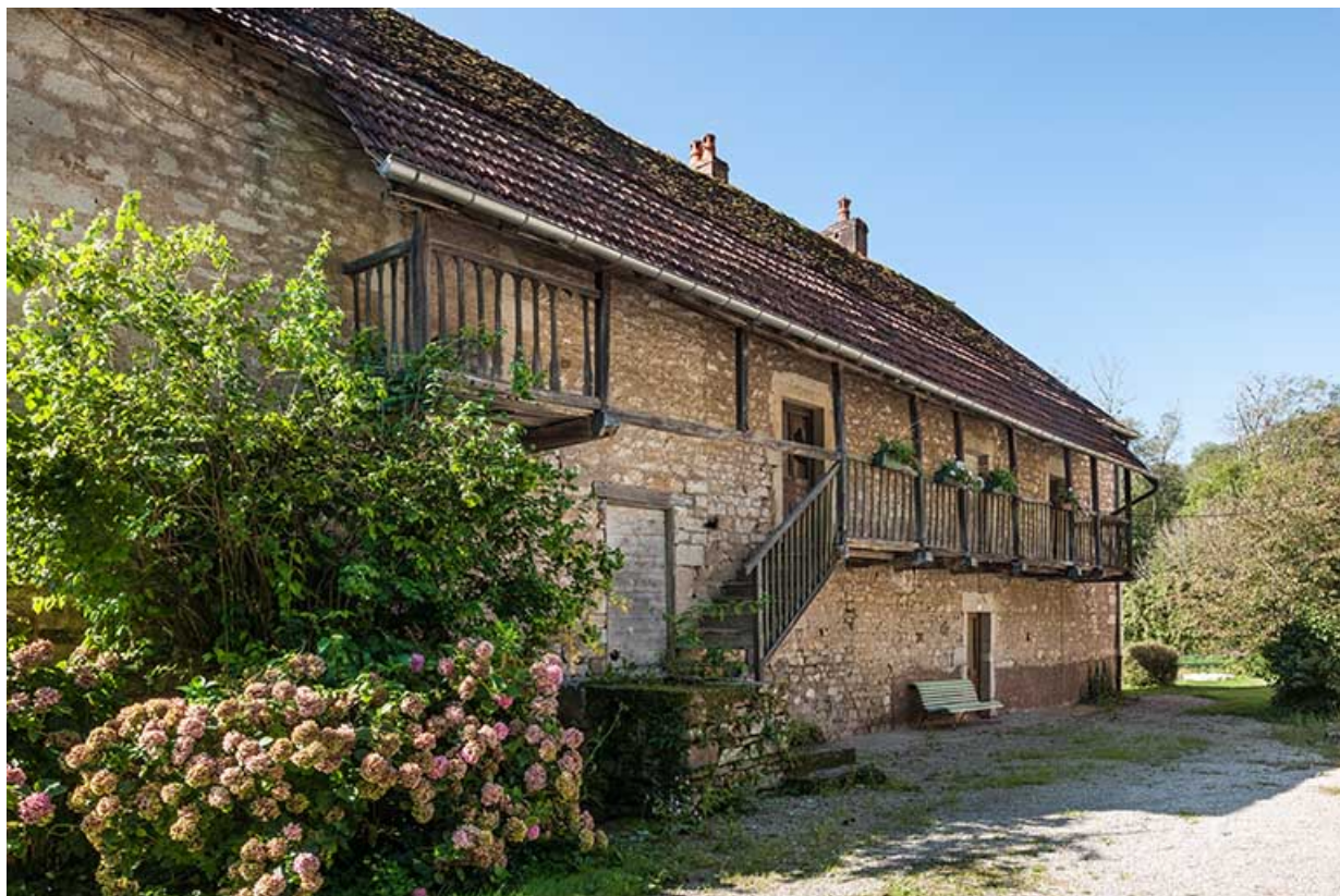
Façade nord du logement patronal.
