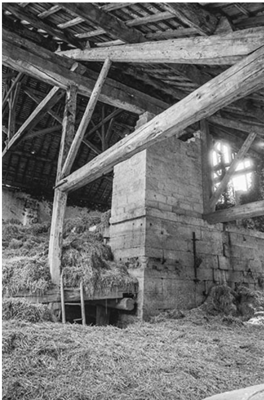
Partie supérieure du haut-fourneau.
