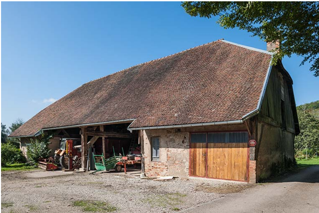
Façade est du magasin industriel.
