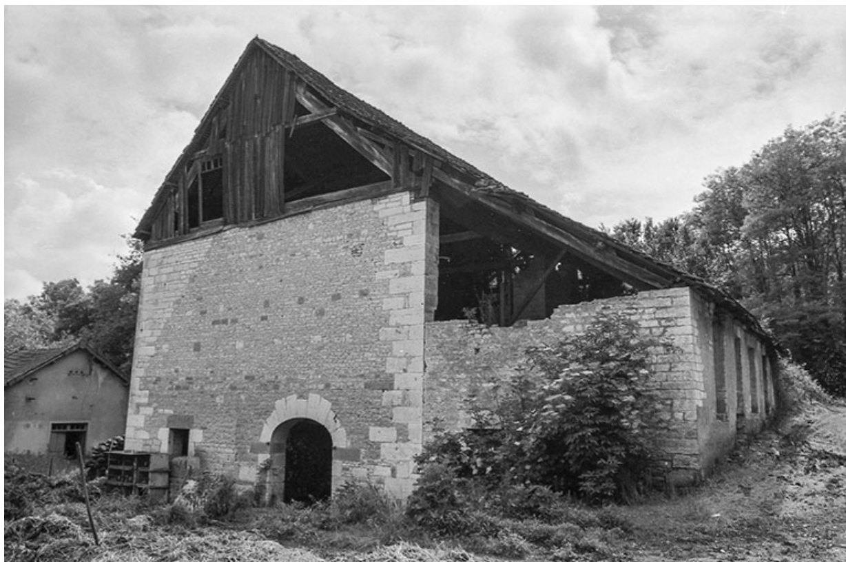
Le bâtiment du haut-fourneau.
