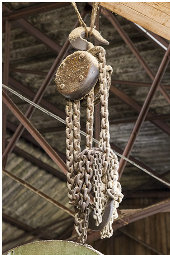
Atelier de fabrication de 1953 : palan manuel.
