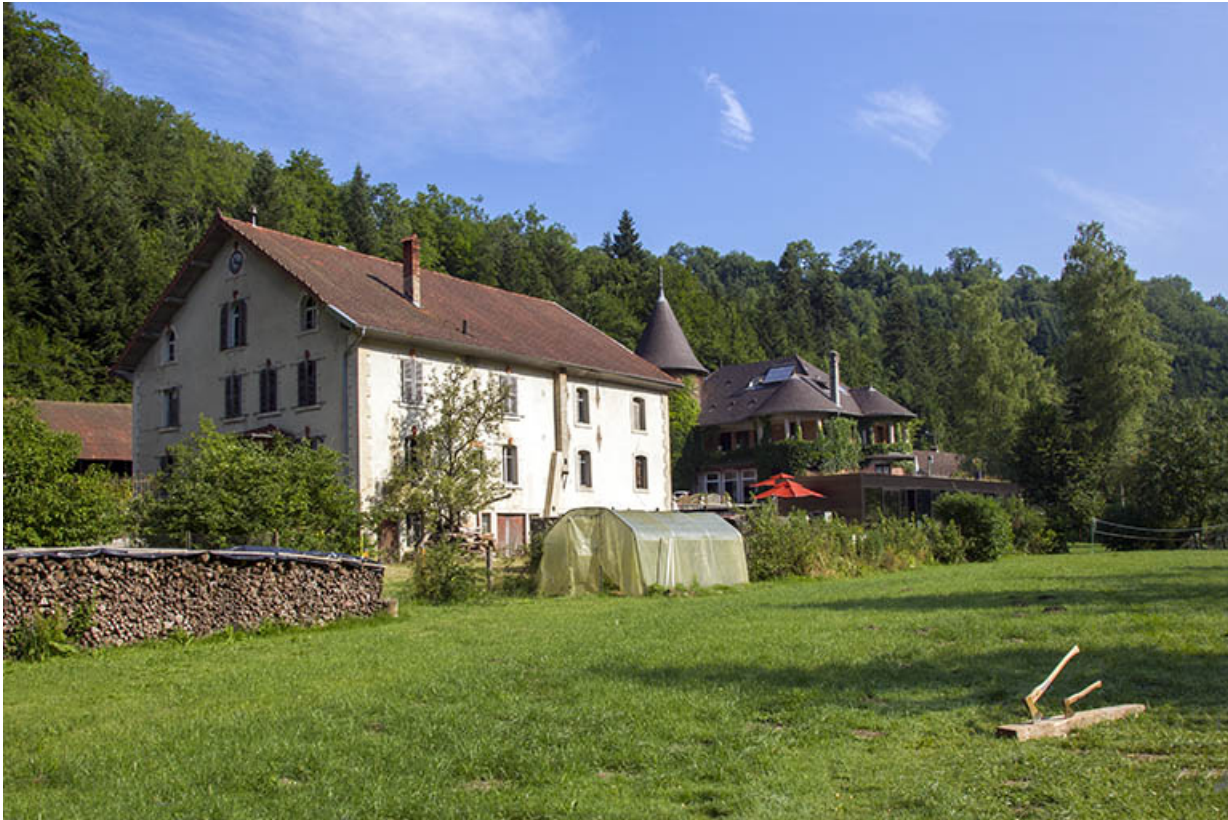
Vue d'ensemble du site, depuis le sud-est.
