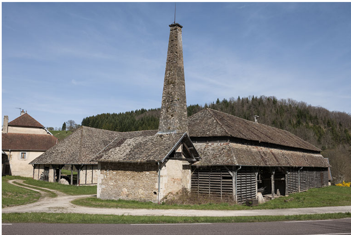
Vue rapprochée depuis le sud-ouest.
