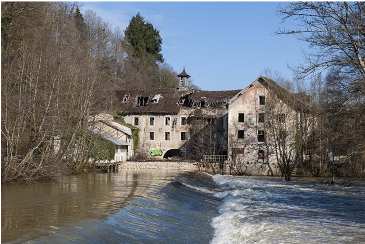
Vue depuis la rive droite du barrage.
