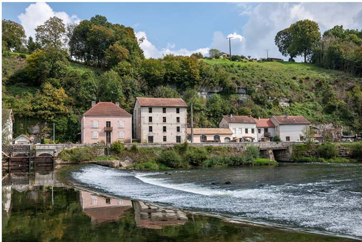
Vue d'ensemble depuis la rive droite.
