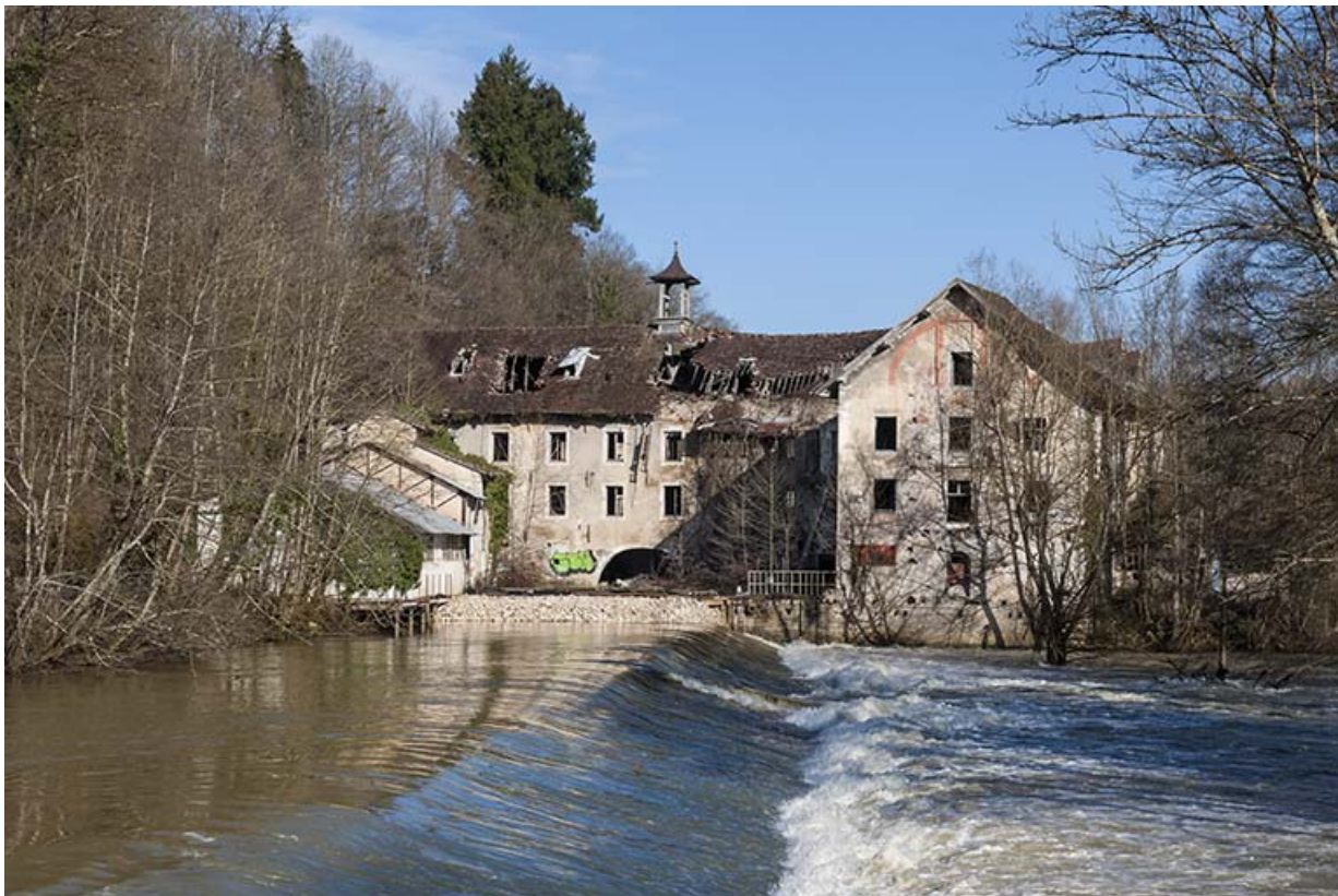
Vue depuis la rive droite du barrage.
