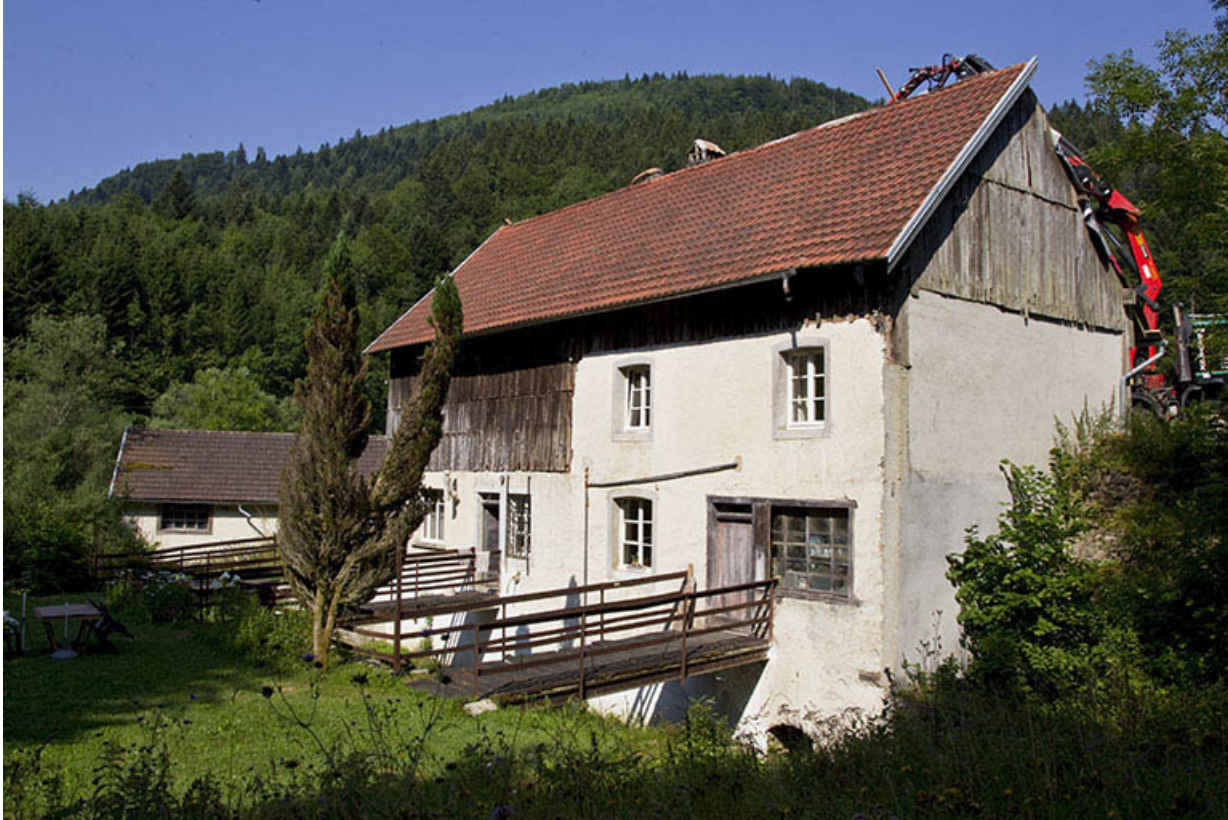
Scierie : façades postérieure et latérale gauche.
