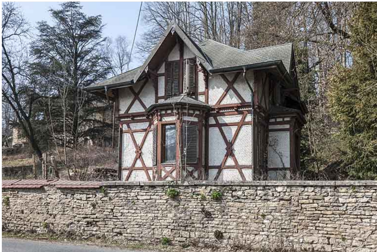
Façade sud de la conciergerie.
