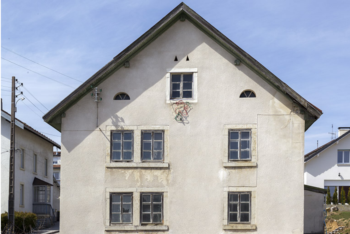
Façade latérale droite.
