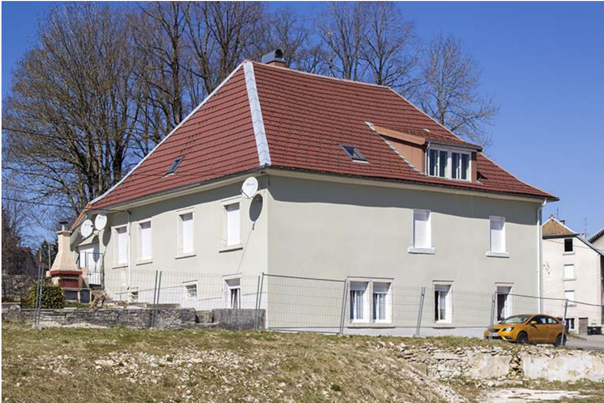
Façades postérieure et latérale droite.
