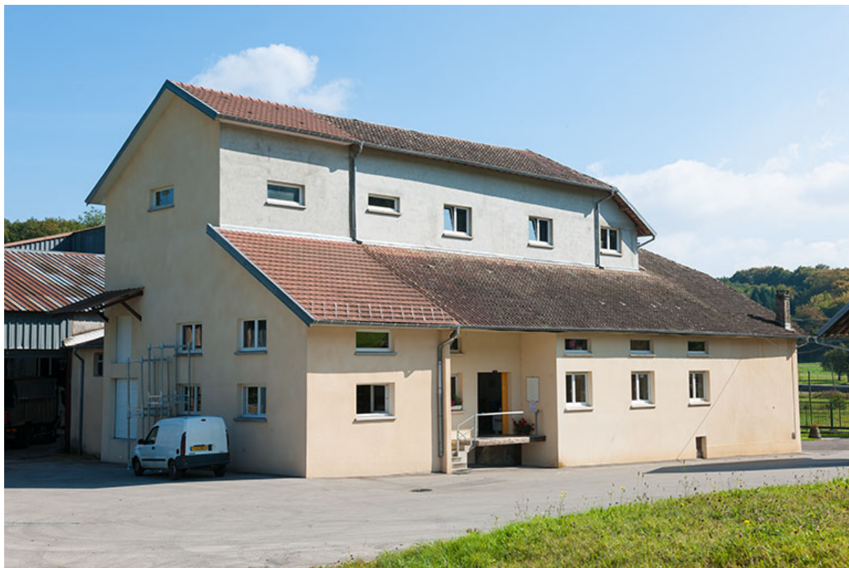
L'atelier du moulin, depuis le nord-est.
