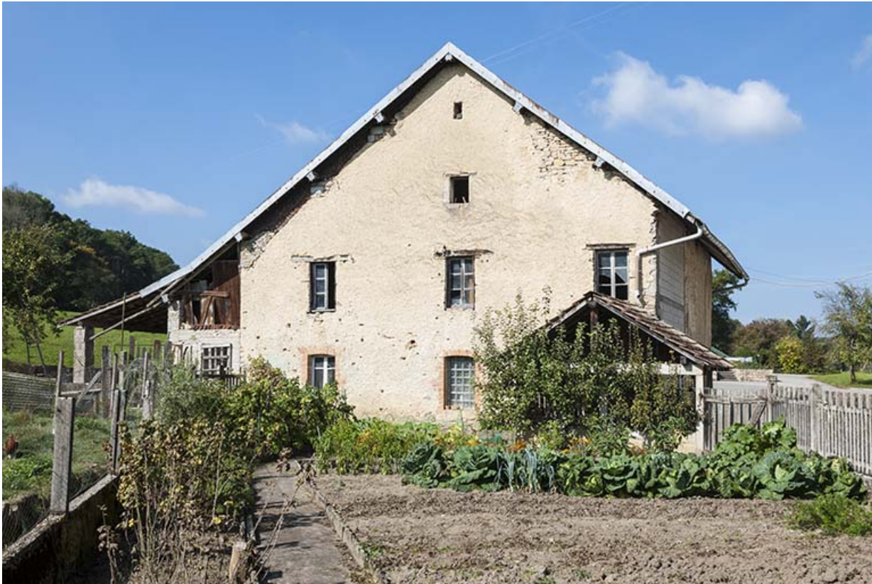
Vestige de la ferme, depuis le sud.
