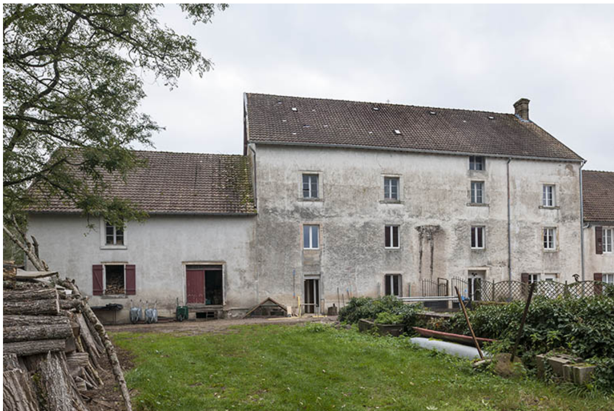
Façade ouest de l'atelier de minoterie.
