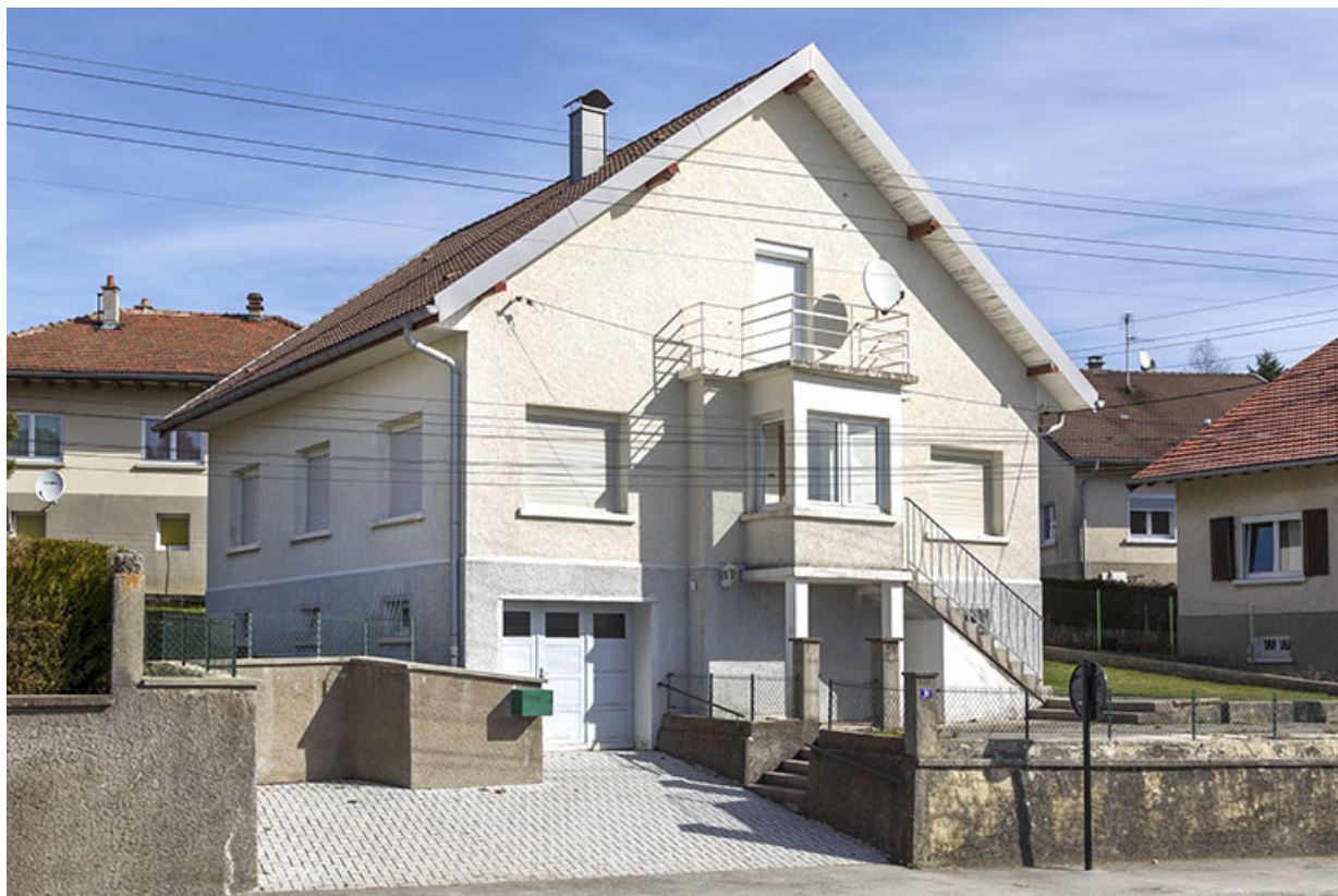
Façades antérieure et latérale gauche.
