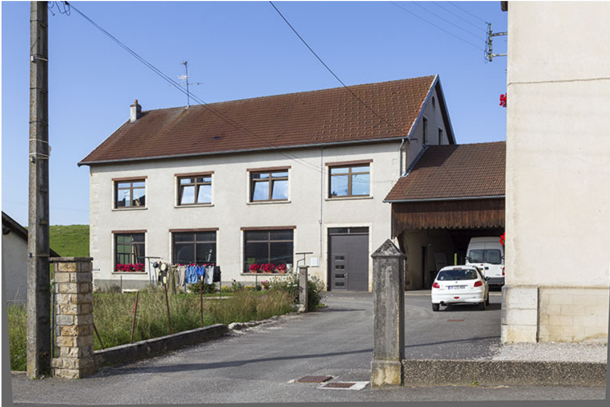
Ancienne fonderie : façade antérieure.
