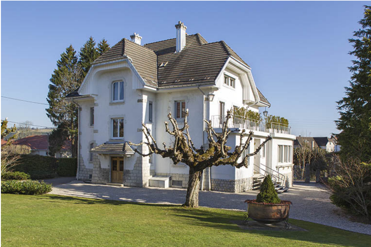
Façades postérieure et latérale gauche.
