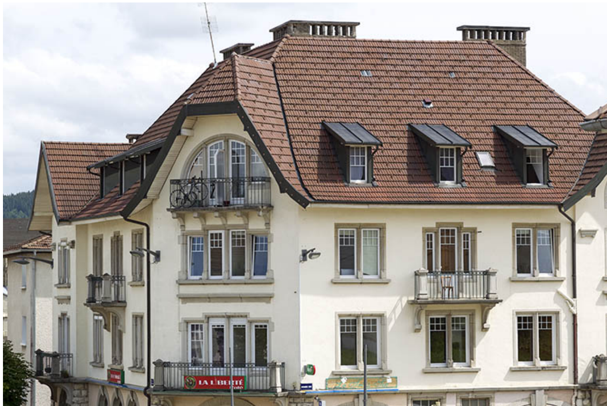
Façade antérieure et pan coupé : niveaux supérieurs.
