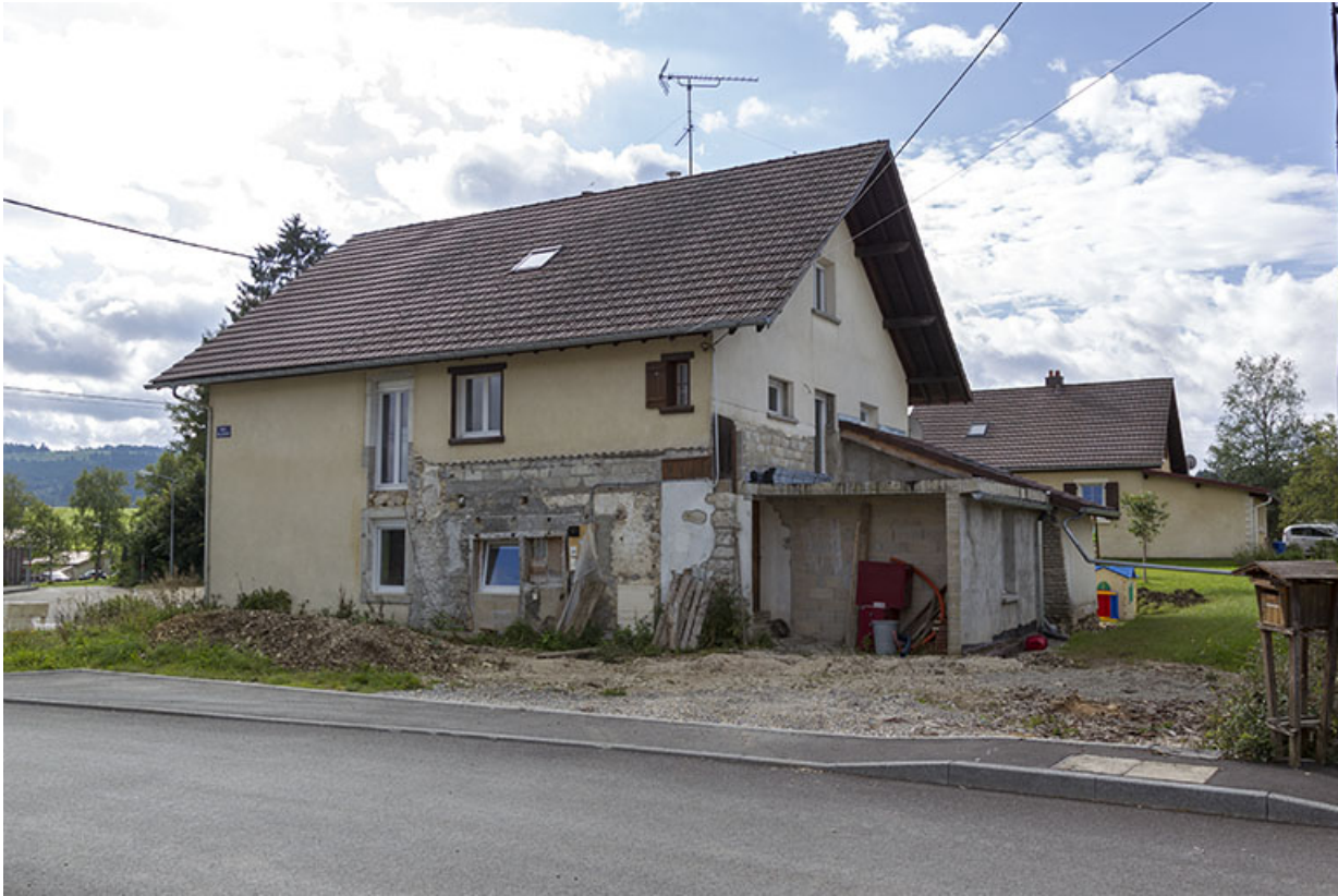
Bâtiment vu du nord.
