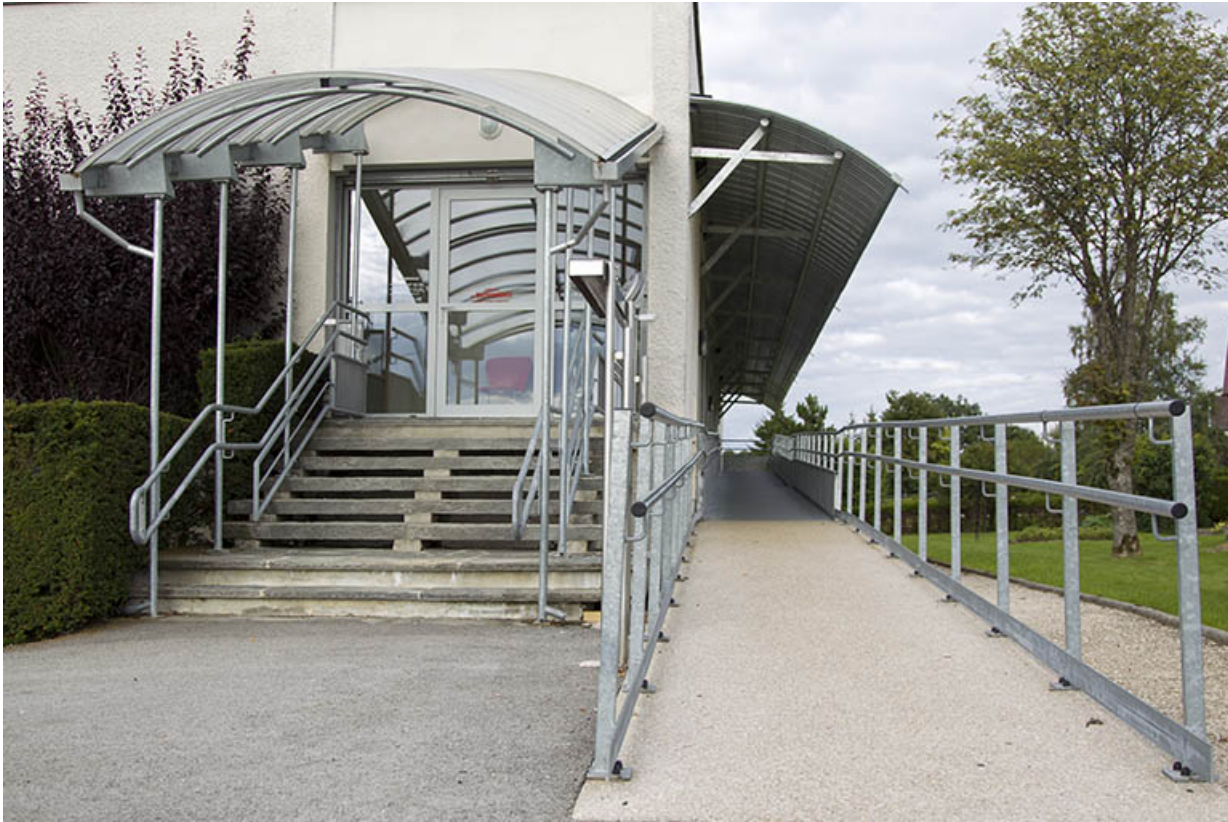
Façade latérale droite : escalier et rampe d'accès.
