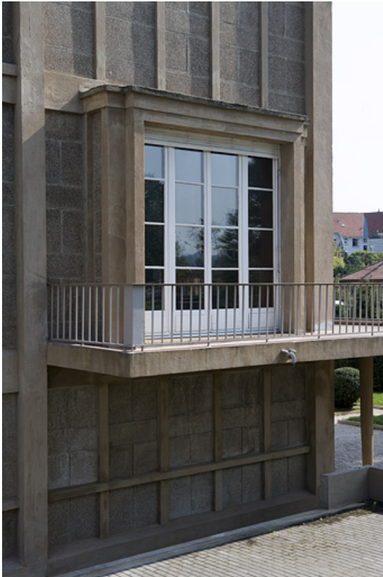
Façade postérieure : porte-fenêtre.
