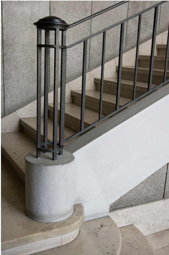
Corps d'entrée : départ de rampe.
