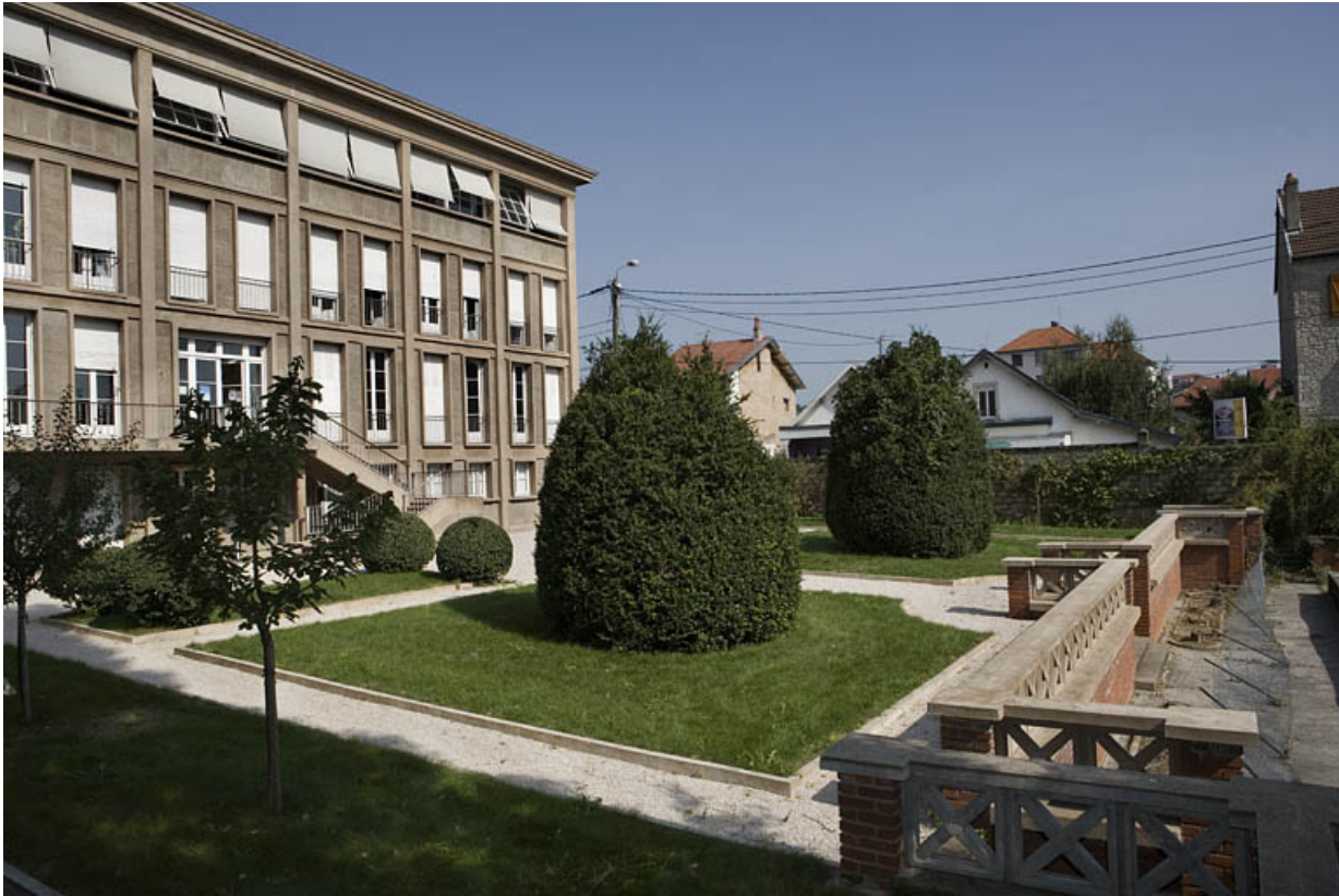
Jardin et face latérale gauche de l'usine.
