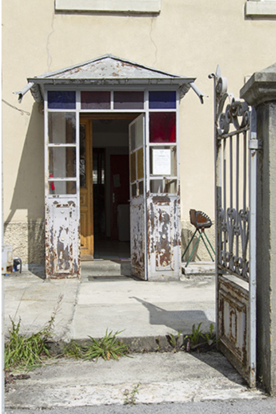
Façade antérieure : entrée.
