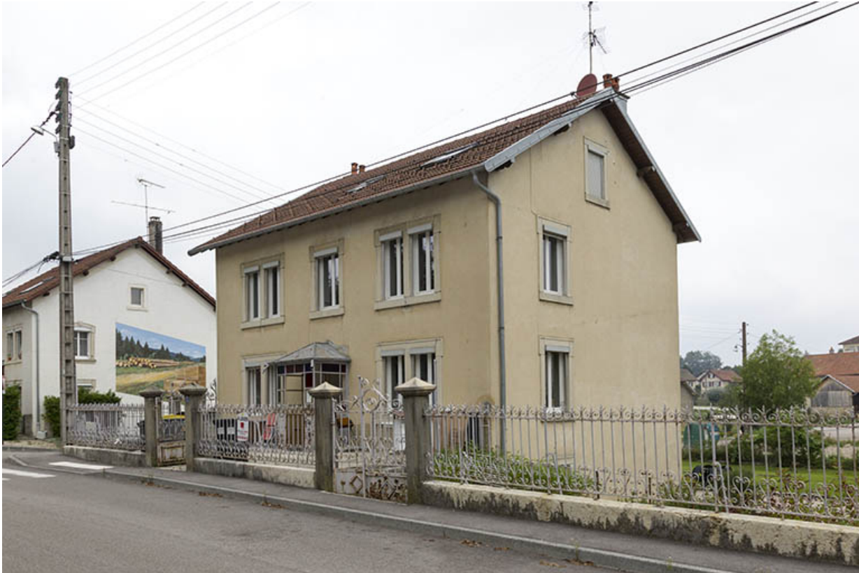
Façades antérieure et latérale droite.
