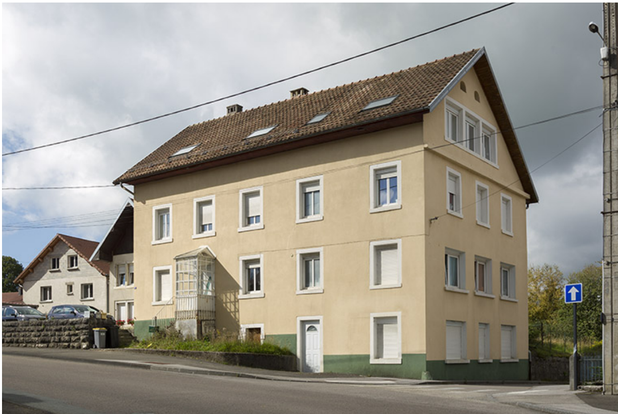
Façades antérieure et latérale droite.
