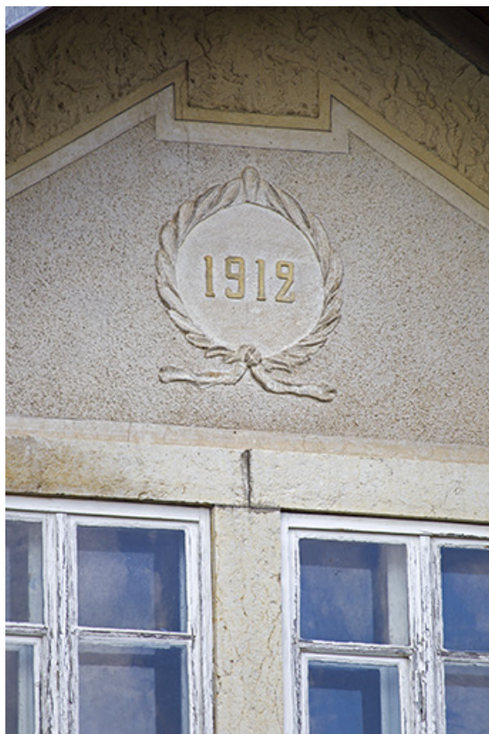
Façade latérale droite : date sur le pignon.
