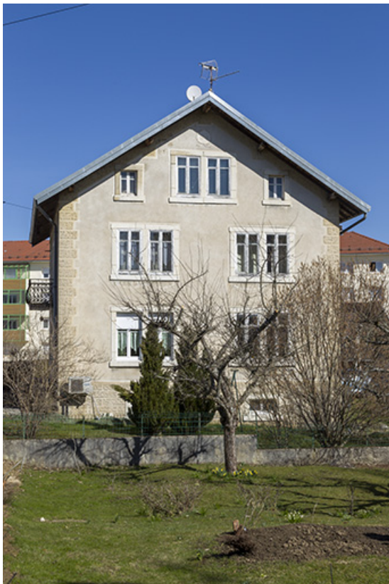
Façade latérale droite.
