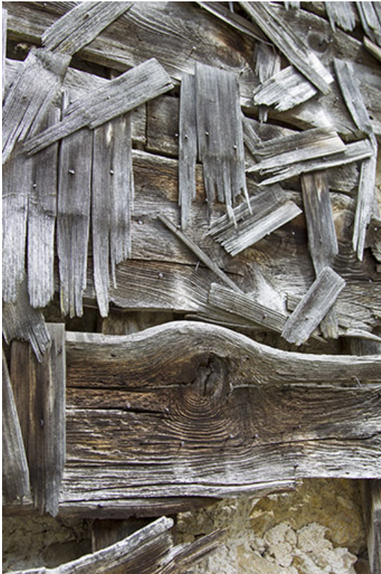
Façade postérieure : support de l'essentage de tavaillons, avec quelques tavaillons. 25, Charquemont, 48 Grande Rue
