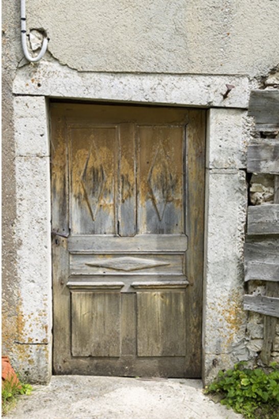
Façade postérieure : porte.
