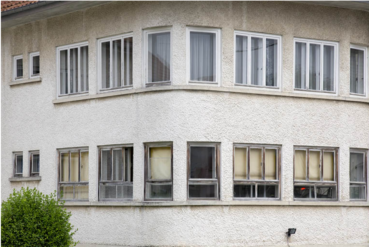
Fenêtres du corps de bâtiment de 1965.
