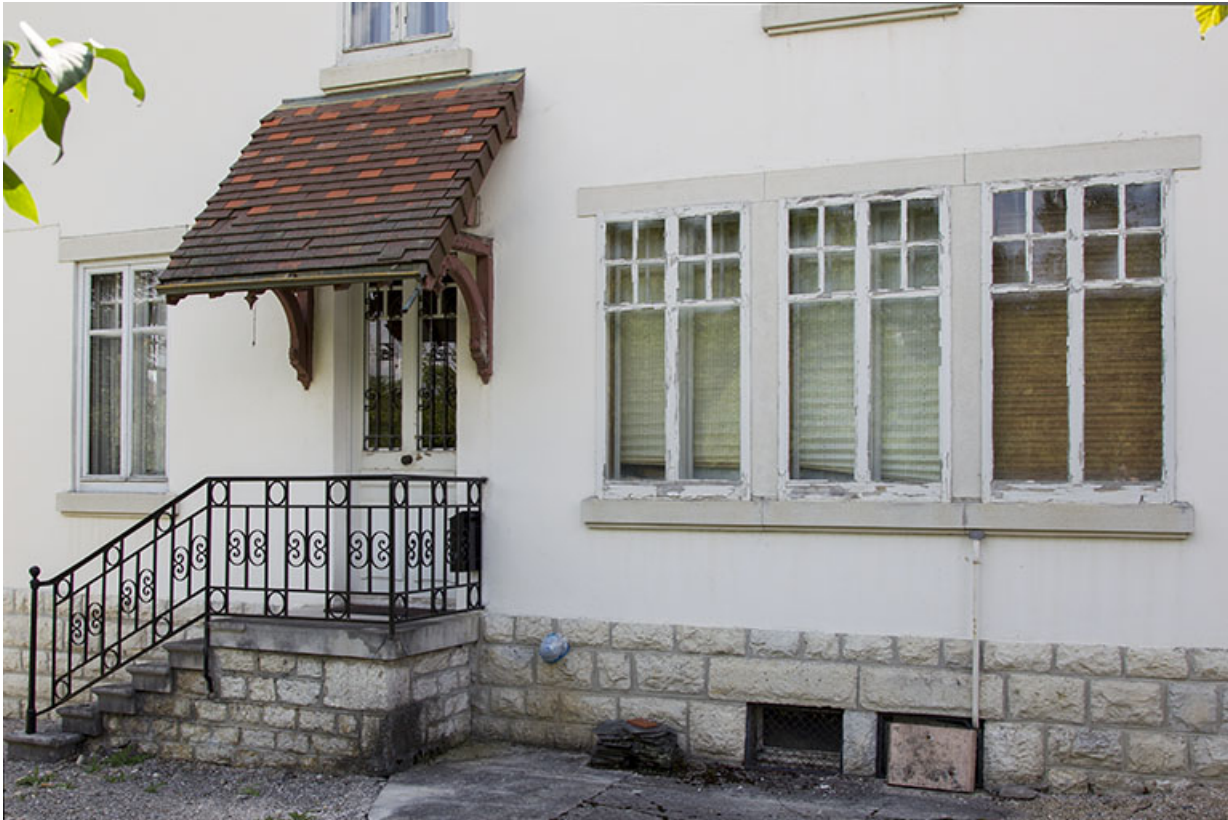
Façade latérale droite : entrée et fenêtres multiples.
