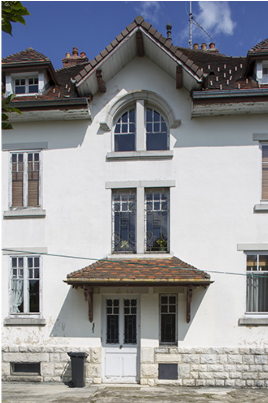
Façade latérale gauche : la travée centrale.
