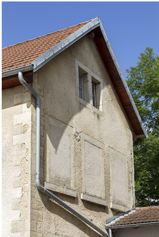
Mur pignon nord-est et ses fenêtres.
