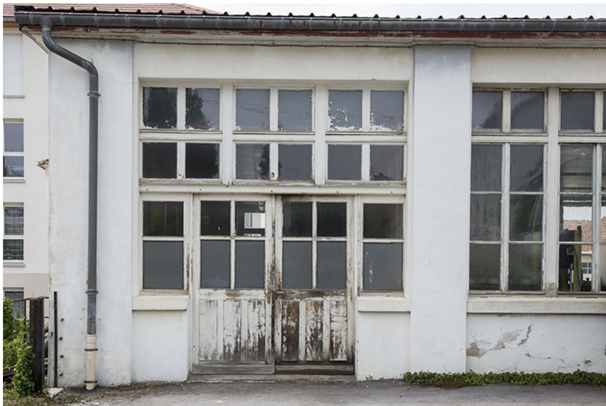
Extension : dernière travée sur la rue Pasteur.
