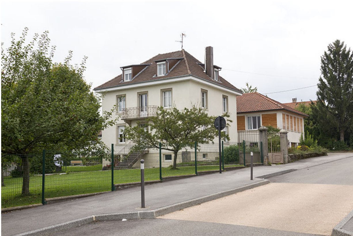
Vue d'ensemble du site, depuis l'est.
