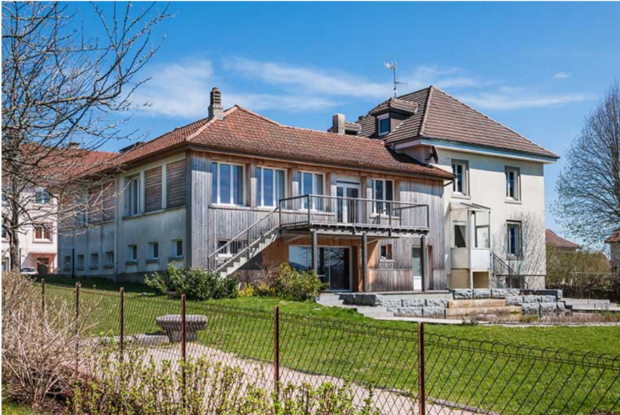
Usine : façades postérieure et latérale droite.
