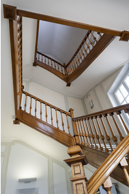
Hall d'entrée : cage d'escalier, vue en contre-plongée.
