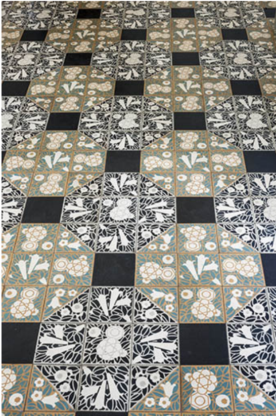
Hall d'entrée : carrelage.
